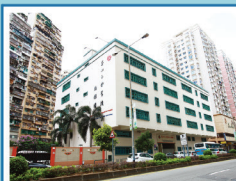
勞校中學附屬幼稚園 林茂海邊大馬路588號 Jardim de Infância Anexo à Escola Lou Hau Avenida Marginal do Lam Mau, n.º 588
