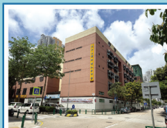
澳門工聯職業技術中學 台山李寶椿街(入口設於巴波沙巷) Escola Secundária Técnico-Profissional da Federação das Associações dos Operários de Macau Rua de Lei Pou Ch'ón (Tóí Sán) (a entrada fica na Travessa de Artur Tamagnini Barbosa)
